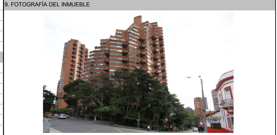
Fuente: Equipo Fotografía PEMP Patrimonio Inmueble
